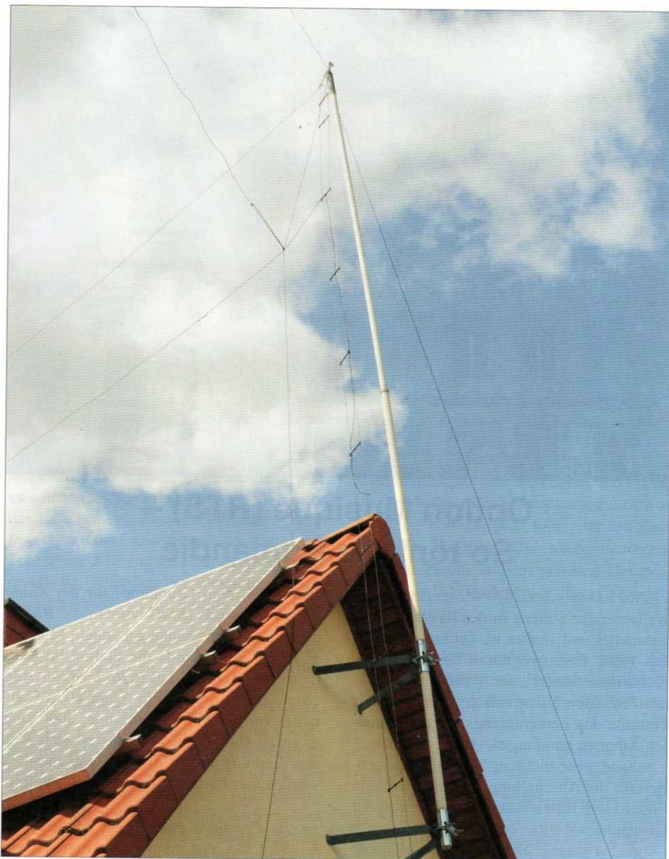
Am oberen Ende des Glasfiberstabes befindet sich der Speisepunkt der Kurzwellenantenne nach G5RV.
